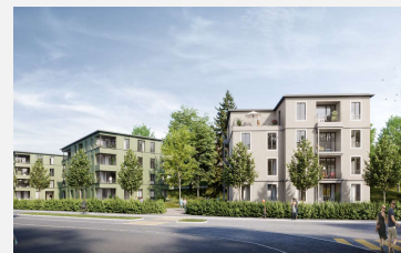
BE – Burgdorf | Bernstrasse «Wohnen mit Services» Geschütztes Wohnen mit Services
