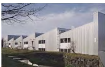
BE – Worb | Bollstrasse 33 «Terra Vecchia» Arbeitsintegration Produktionsbetrieb, Werkstätte
