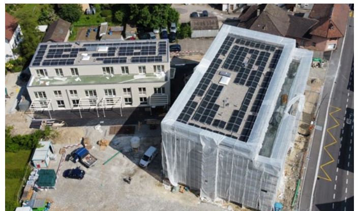
Silbergarten, Deredingen (ZEV)
